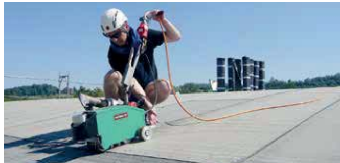
De BITUMAT B2 last zonder open vuur gemodificeerd bitumen.
