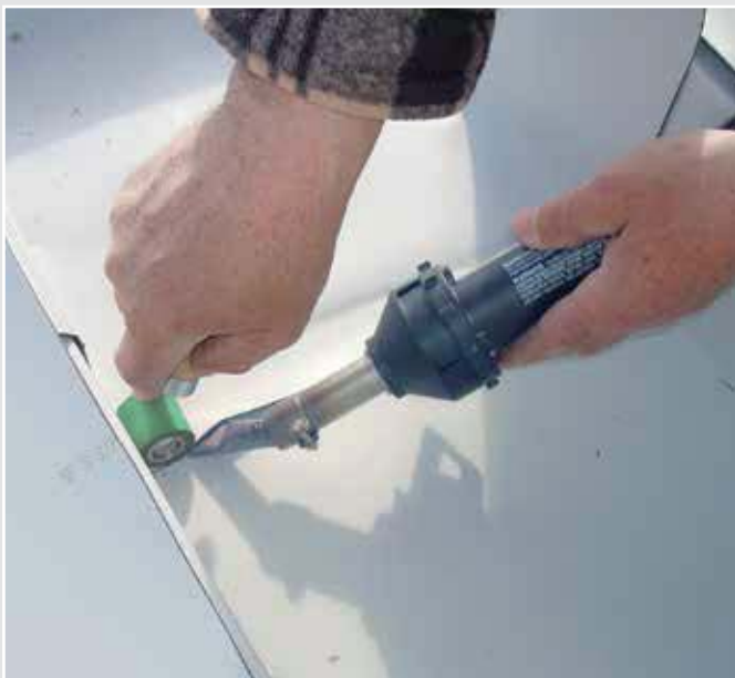
Hot-Jet S ideaal voor detailwerk op het dak.
