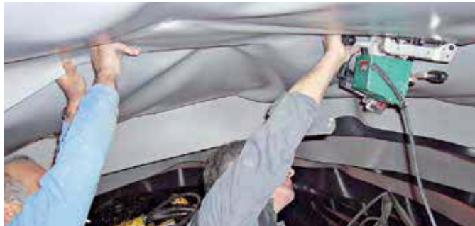
De COMET bij tunnelbouw-
