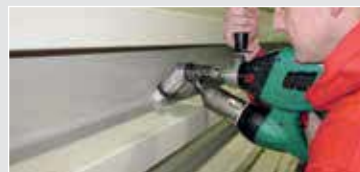
Verlicht het lassen in moeilijke posities: De 45°-hoekadapter van de WELDPLAST S2. (toebehoren)
