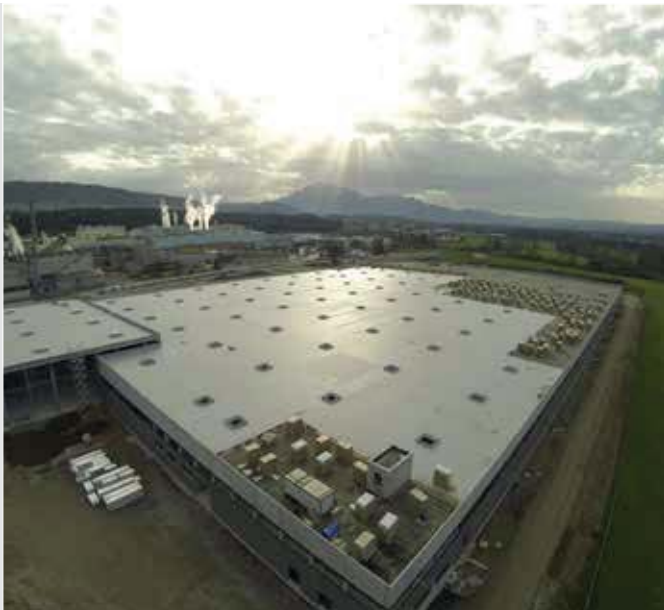
Aldi logistiek centrum 50000m2 TPO Membraan, Zwitserland
