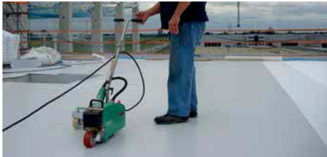
Simpele geleiding van het lasapparaat en hoge lascapaciteit.
