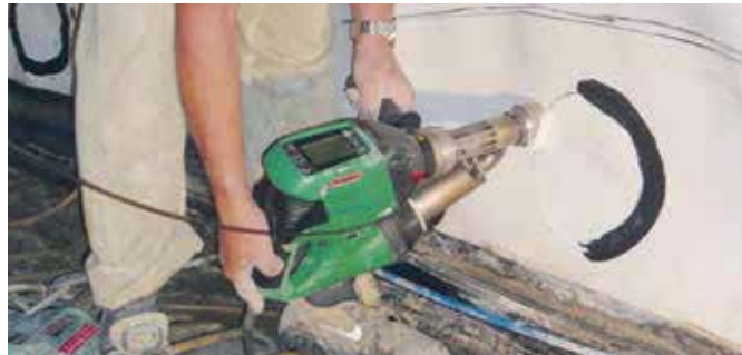
De robuuste WELDPLAST S2 tijdens het lassen van een detail in een tunnel.
