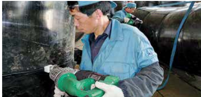
De FUSION 2 bij de bouw van opslagvaten in China.
