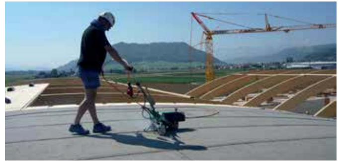
Eenvoudig begeleiden van het lasapparaat en schoon werken met de BITUMAT B2.
